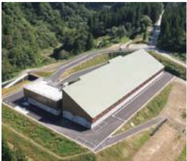
完成した十日町市海老最終処分場
