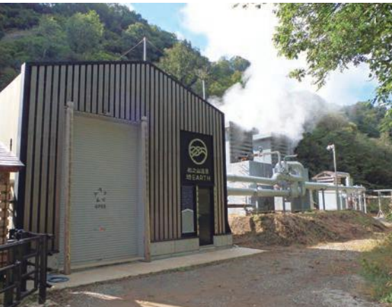
松之山温泉の蒸気や熱水を活用した地熱バイナリー発電所 「コミュニティ発電 ザ・松之山温泉」
