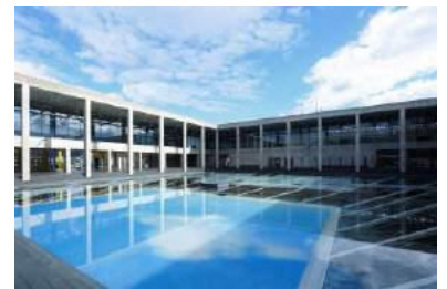
美術館外観 レアンドロ・エルリッヒ「Palimpsest:空の池」 Photo by Kioku Keizo
