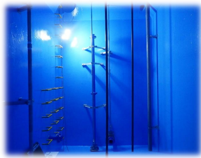
角間配水池の水槽内
