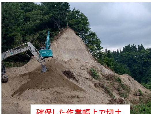
確保した作業幅上で切土
