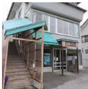
外観 (2・3階部分が棚田ステーション)
