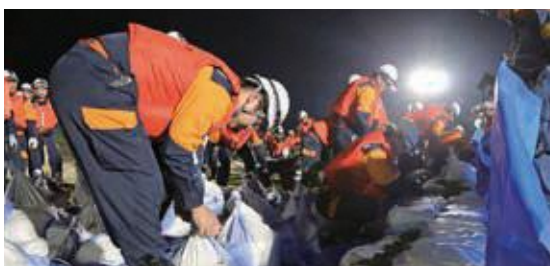
従来の土のう積み比べ、より強固で安定した堤防を迅速に構築できる「改良積み土のう工法」
