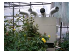
燃油使用量の低減に資する施設園芸用ヒートポンプ
