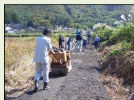
未舗装農道の舗装
