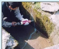
ひび割れの補修
