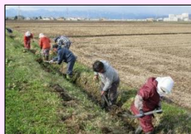
水路の泥上げ
