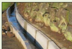
素堀り水路からの更新
