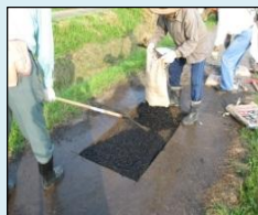
農道の部分補修
