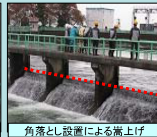
角落し設置による嵩上げ
