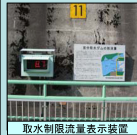
取水制限流量表示装置
