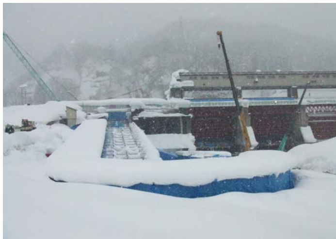
工事施工状況
