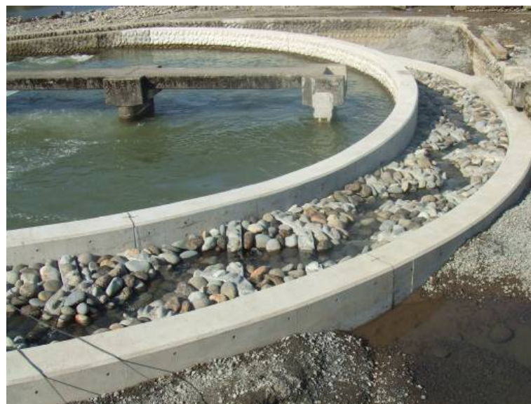
せせらぎ魚道施工完了箇所
