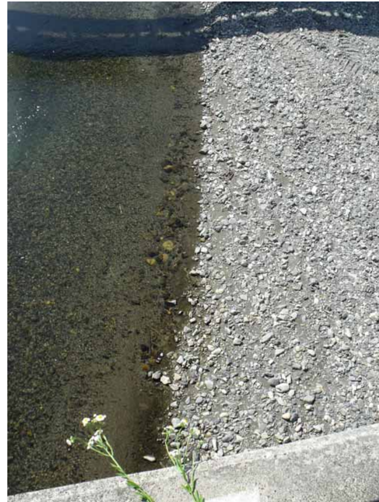
三面川左支川門前川・坪根橋地点 2012・6・13大熊撮影
