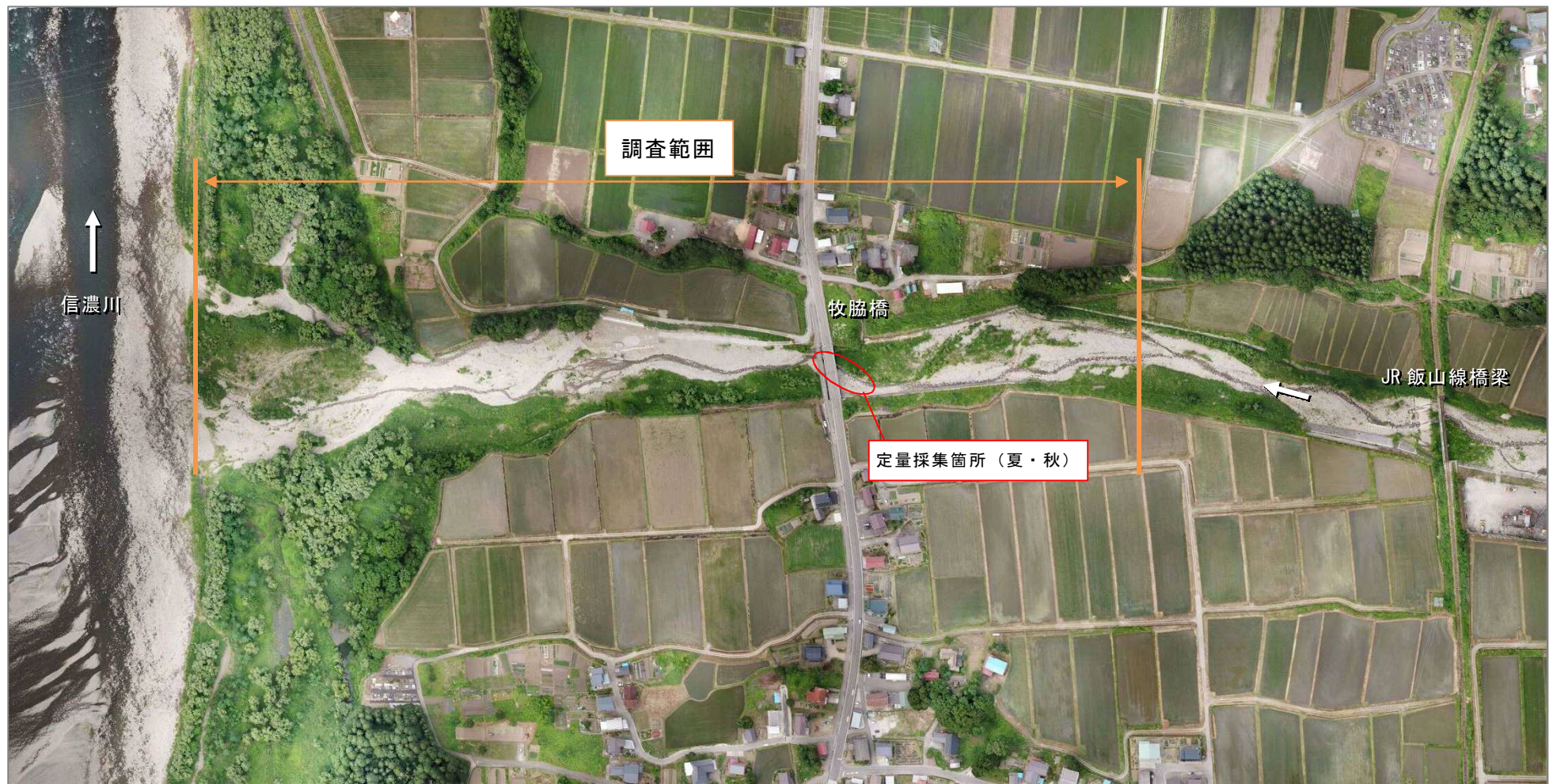
図 2-2 (1) 入間川調査地点 (信濃川合流点付近 : 平成 30 年 6 月 26 日撮影)
