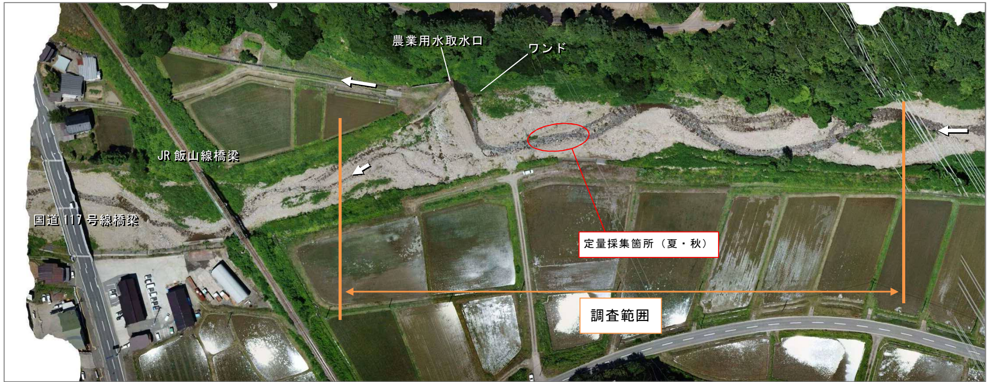
図 2-2 (2) 当間川調査地点 (JR 飯山線橋梁上流 : 平成 30 年 6 月 22 日撮影)
