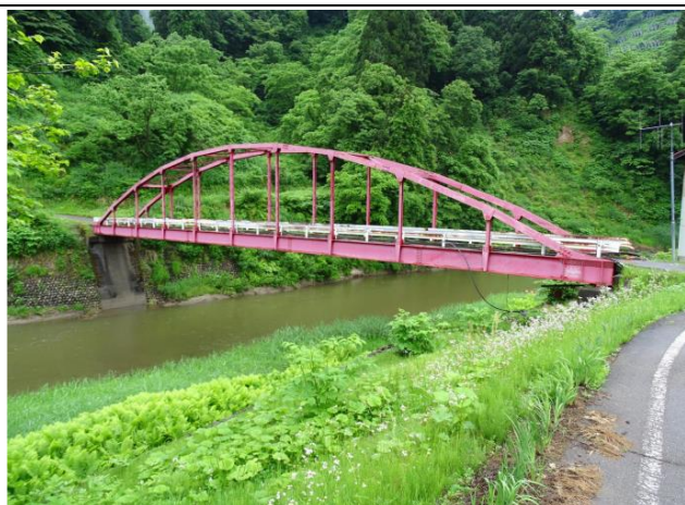
写真全景（鋼橋）
