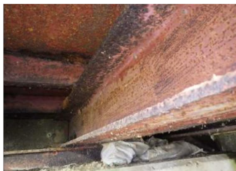
鋼桁の腐食等
