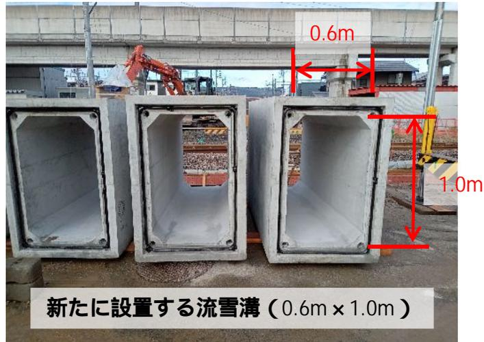
新たに設置する流雪溝 (0.6m x 1.0m)
