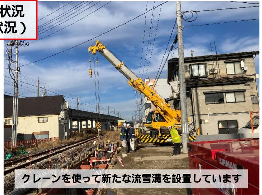
クレーンを使って新たな流雪溝を設置しています
