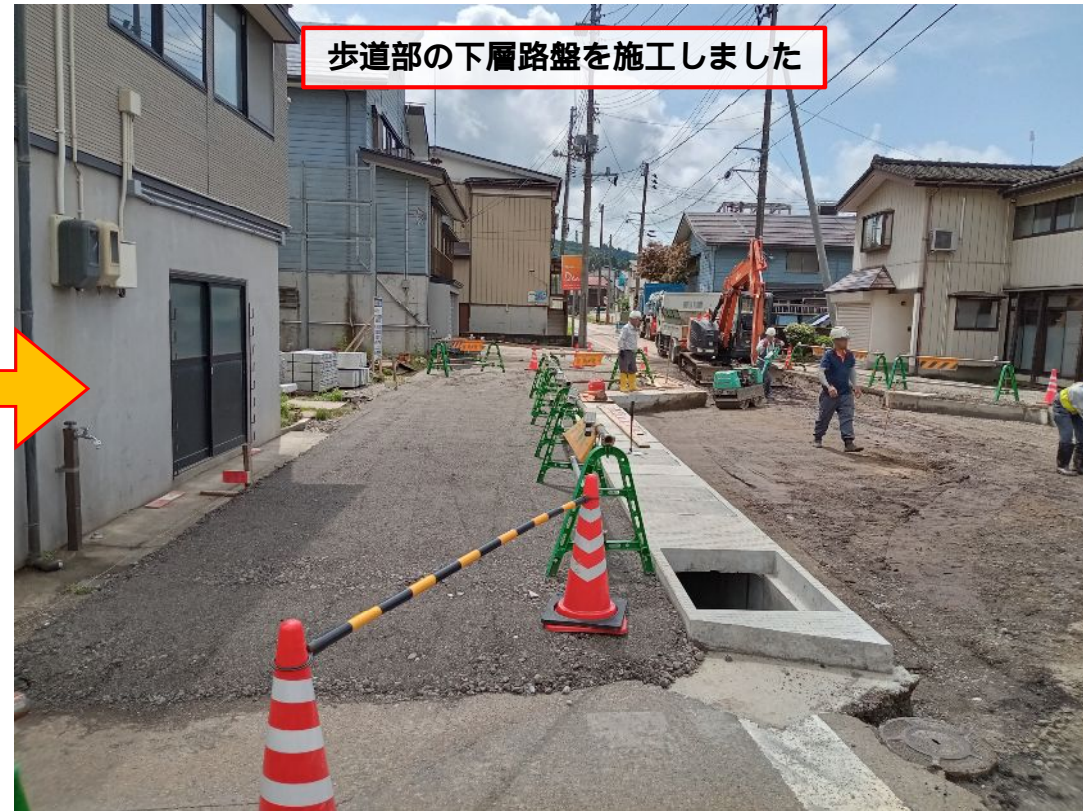
歩道と車道の境に設置するブロック (歩車道境界ブロック)
