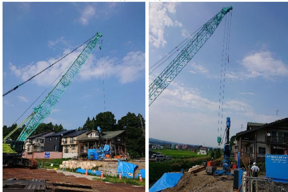
橋げた撤去後、大型のクローラークレーンを使用して橋台を撤去するための準備工を行っています。現在は、矢板といわれる凹凸のある鉄板を土中に埋め込む作業をしています。矢板を埋めることによって、川の斜面が崩れることを防ぎます。
