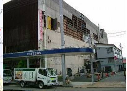
旧娯楽会館：平成16年の中越大震災により被災し廃業した大型商業ビル（平成24年8月に解体）
