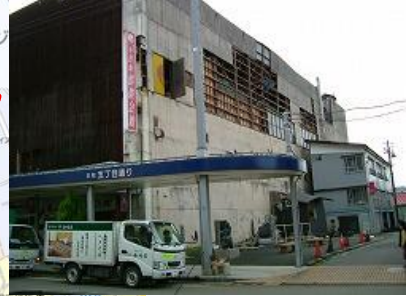
旧娯楽会館：平成16年の中越大震災により被災し廃業した大型商業ビル（平成24年8月に解体）
