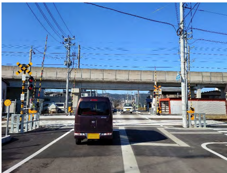
JR 飯山線稲荷町踏切拡幅工事
