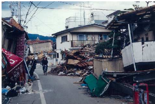
[阪神・淡路大震災での道路閉塞の状況]
