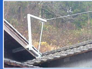
破風に金具を取り付け
