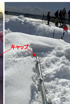
屋根端部を把握するため屋根端から1mの位置で単管を止める 単管端に付けた黄色いキャップが危険ゾーンの目印
