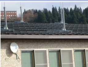
支柱に直接命綱を固定する
