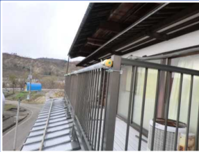
単管パイプを使用
