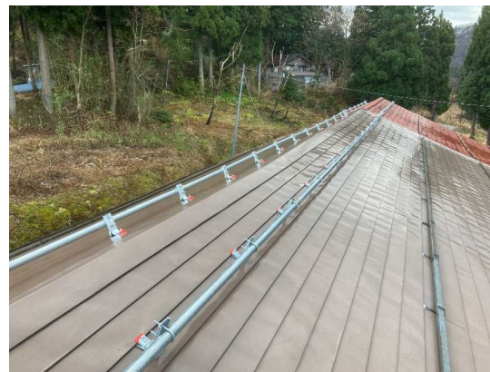
平葺き金属屋根に取付
