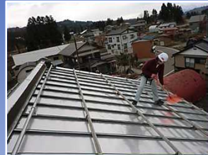
列状に単管パイプを配置
