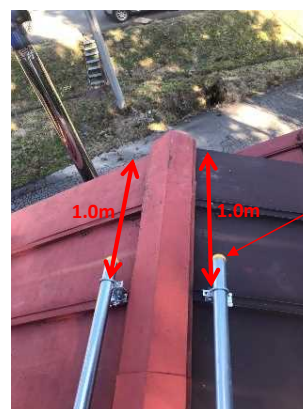
屋根端部を把握するため屋根端から1mの位置で単管を止める 単管端に付けた黄色いキャップが危険ゾーンの目印
