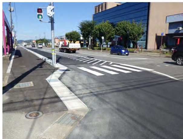
高山太子堂線の歩道整備
