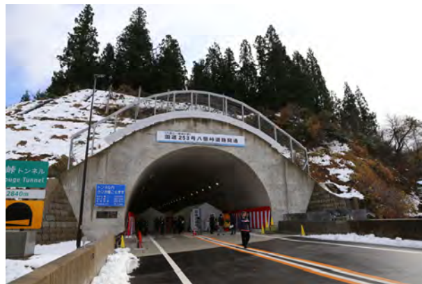
国道 253 号八箇峠トンネル
