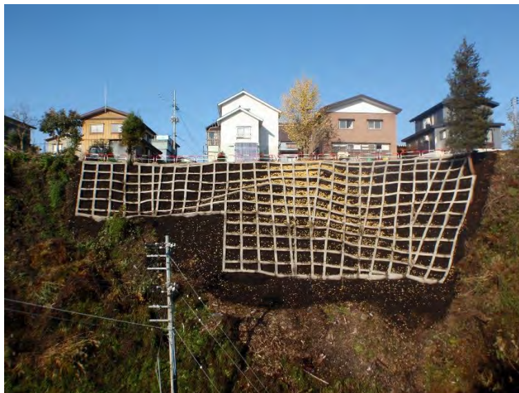
斜面崩壊防止対策（山野田地内）
