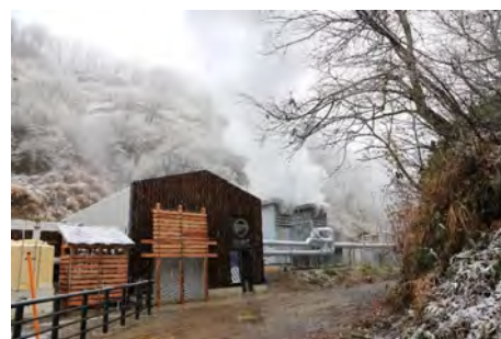
松之山温泉の地熱バイナリー発電所
