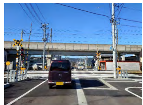
JR 飯山線稲荷町踏切拡幅工事
