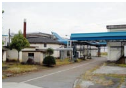
老朽化が進み対応が急がれるし尿処理センター
