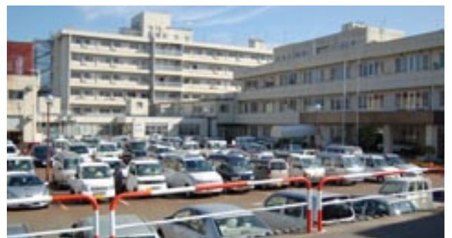
利用者車両で混みあう十日町病院
