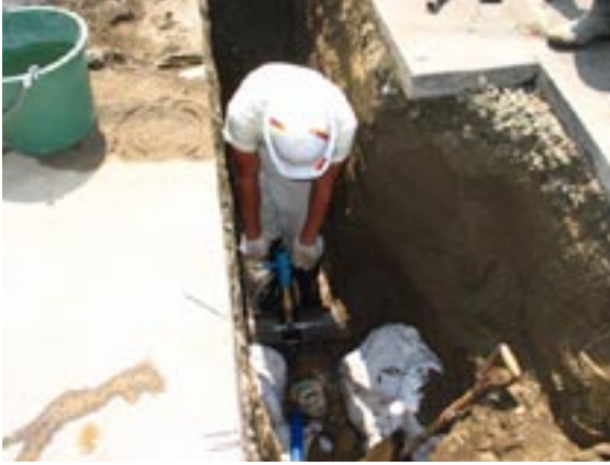
給水管取り出し工事
