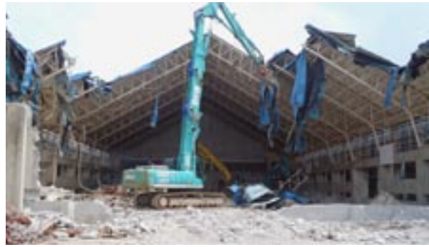
十日町中学校屋内体育館の解体
