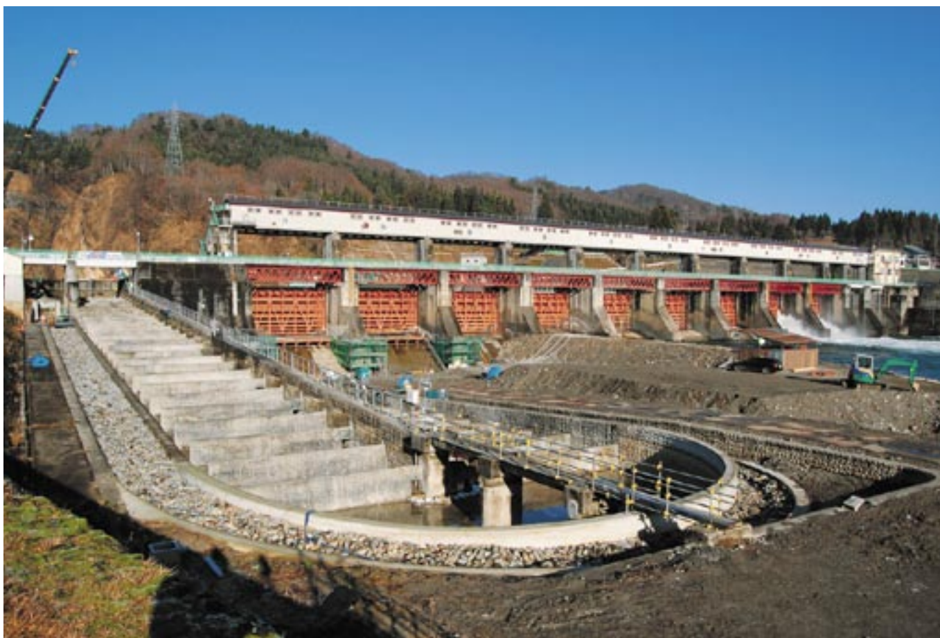
魚道工事が進む宮中取水ダム (2011/12/14撮影)
