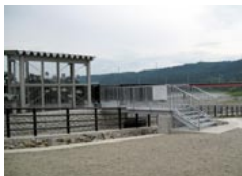
宮中取水ダム魚道観察室
