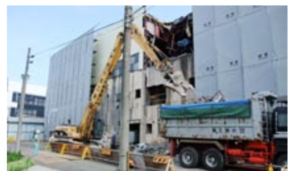
解体が進む旧娯楽会館
