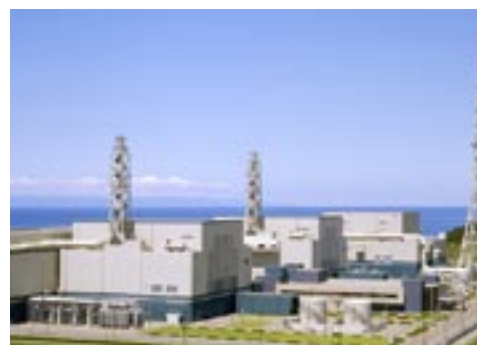
柏崎刈羽原子力発電所
