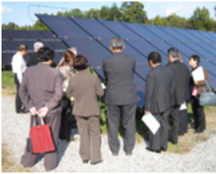
「北杜サイト」の太陽光パネル
