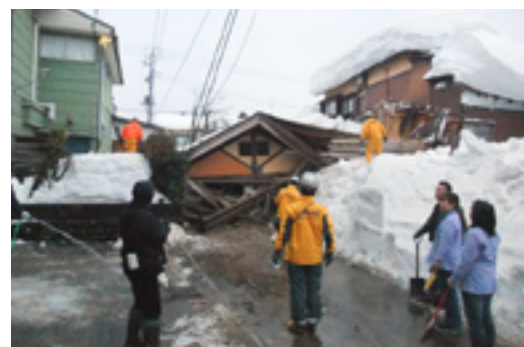
雪の重みで倒壊した建物
