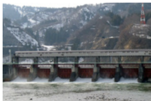
宮中取水ダム
