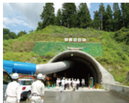
八箇峠トンネル（十日町側）
