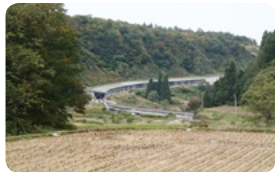
現在工事中の広域農道4号線（当間集落手前付近）
