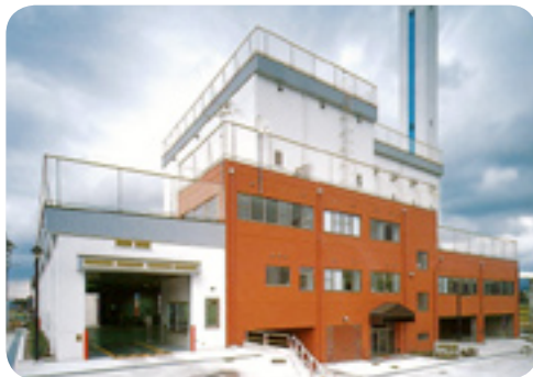
焼却施設を大規模改修するエコクリーンセンター
