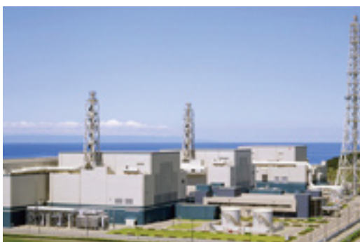
柏崎刈羽原子力発電所
