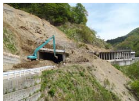
国道353号の土砂撤去作業
