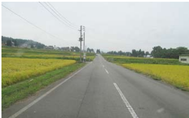
冬季間閉鎖される中条病院協から接続する農道
