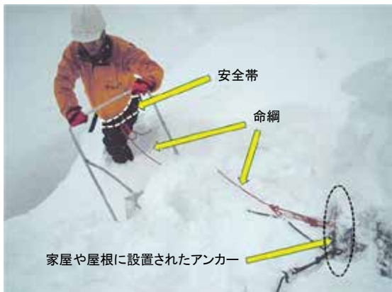
安全帯、命綱、アンカーを使用した雪下ろし作業
