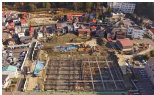
十日町高校隣に建設中の市民文化ホール・中央公民館
