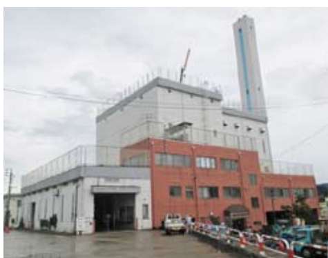
大規模改修中のエコクリーンセンター
