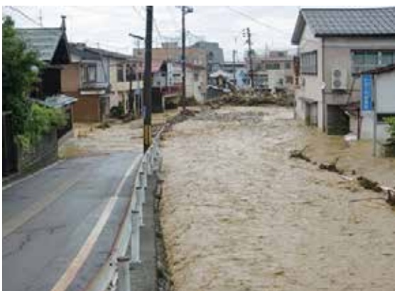
平成23年7月 豪雨災害状況
