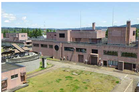
下水処理センター
