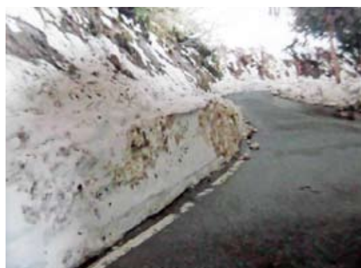
雪庇落とし後の道路（松之山地区高倉地内）
