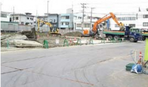
看護専門学校工事現場（H30年9月撮影）
