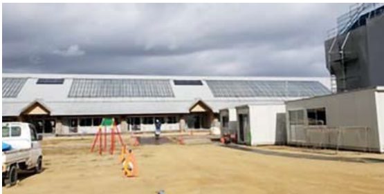
会派で視察した建設中の川内村義務教育学校（福島県）
