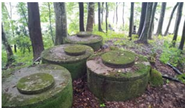
「知恵と努力の結晶」集落で敷設された水道施設
