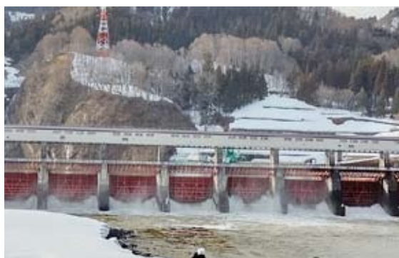
宮中ダム・石炭由来の電力から脱却し 再生可能エネルギーでCO2排出量削減を!
