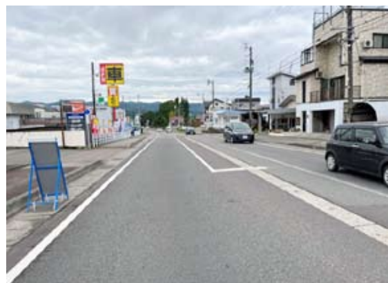
国道253号の非直面世帯が多い区間
