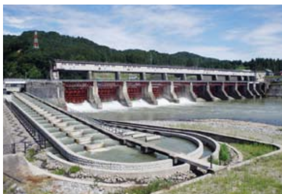
水力発電所予定地 (中里 宮中取水ダム)
