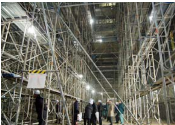
建設中の(仮称)市民文化ホールの内部
