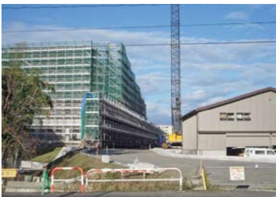
建設中の(仮称)市民文化ホールの外観
