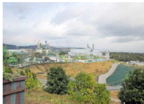
最終処分場と設備群
