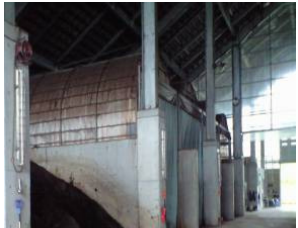
川西有機センター発酵槽
