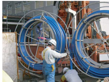
Uチューブ挿入作業（ダブルUチューブ）
